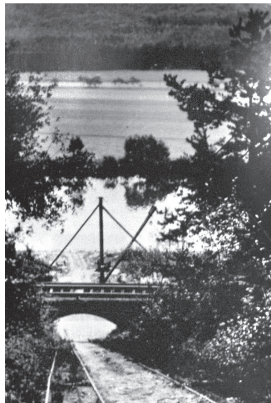
Mit der Bergbremsbahn transportierte man die Steine energiesparend vom Hang herab an den Main.
