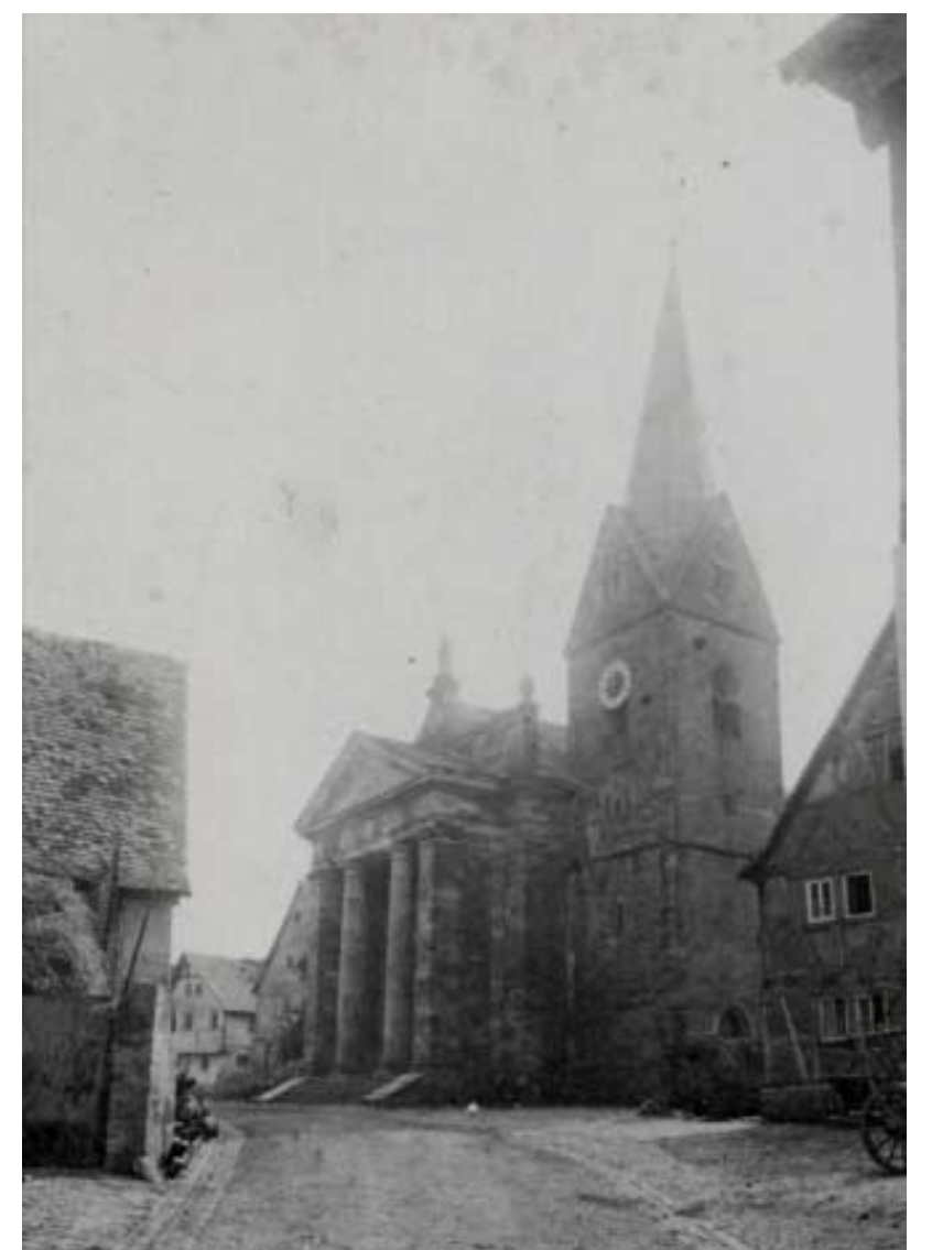
Das älteste Foto der Kirche mit dem klassizistischen Vorbau von Herigoyen mit Treppe.
