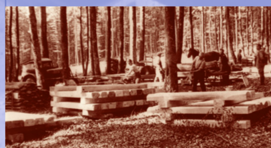
Die Weibersbrunner Schwellenhauer beim Aufsichten der Eisenbahnschwellen (um 1950)
