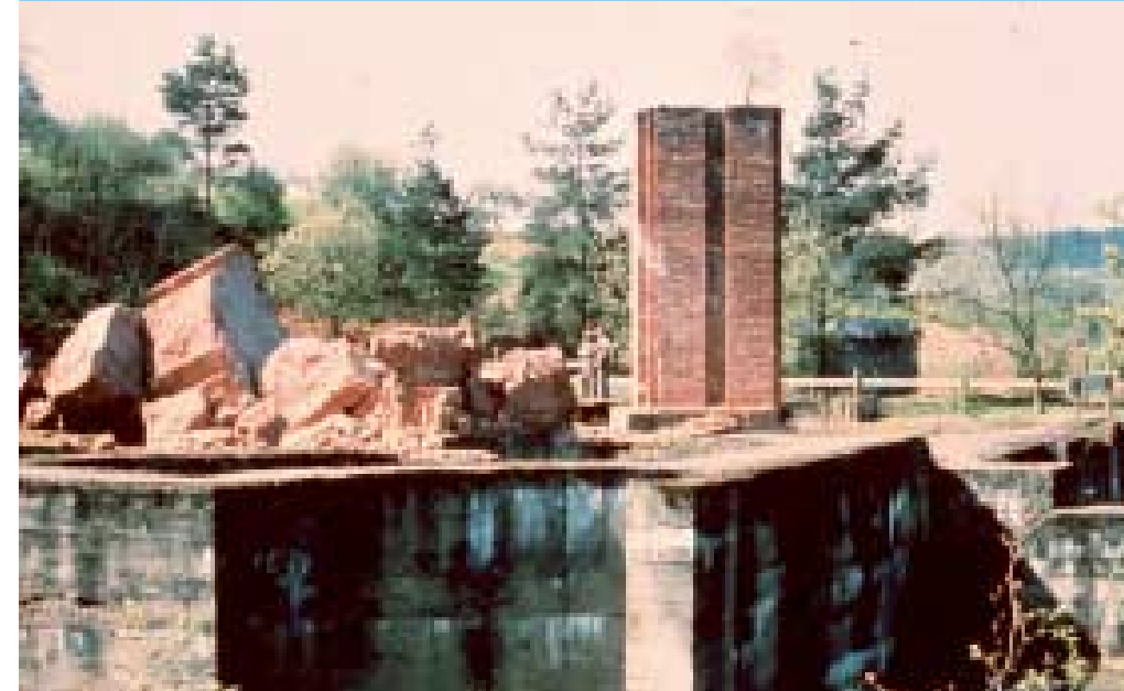
In den 1950er Jahren wurde die Bauruine gesprengt. Danach wurden die Aufbauten abgetragen. Das Fundament bildete den Grundriss für den modernen Kirchenbau.
