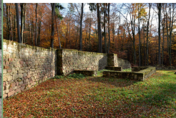
Die unteren Steinlagen der Ringmauer gehören zum Originalbefund, die oberen Lagen wurden im Rahmen der Sanierung aufgemauert. Direkt hinter der Ringmauer stand ein Turm, dessen gemauerter Sockel nachempfunden wurde. Foto: Burglandschaft
