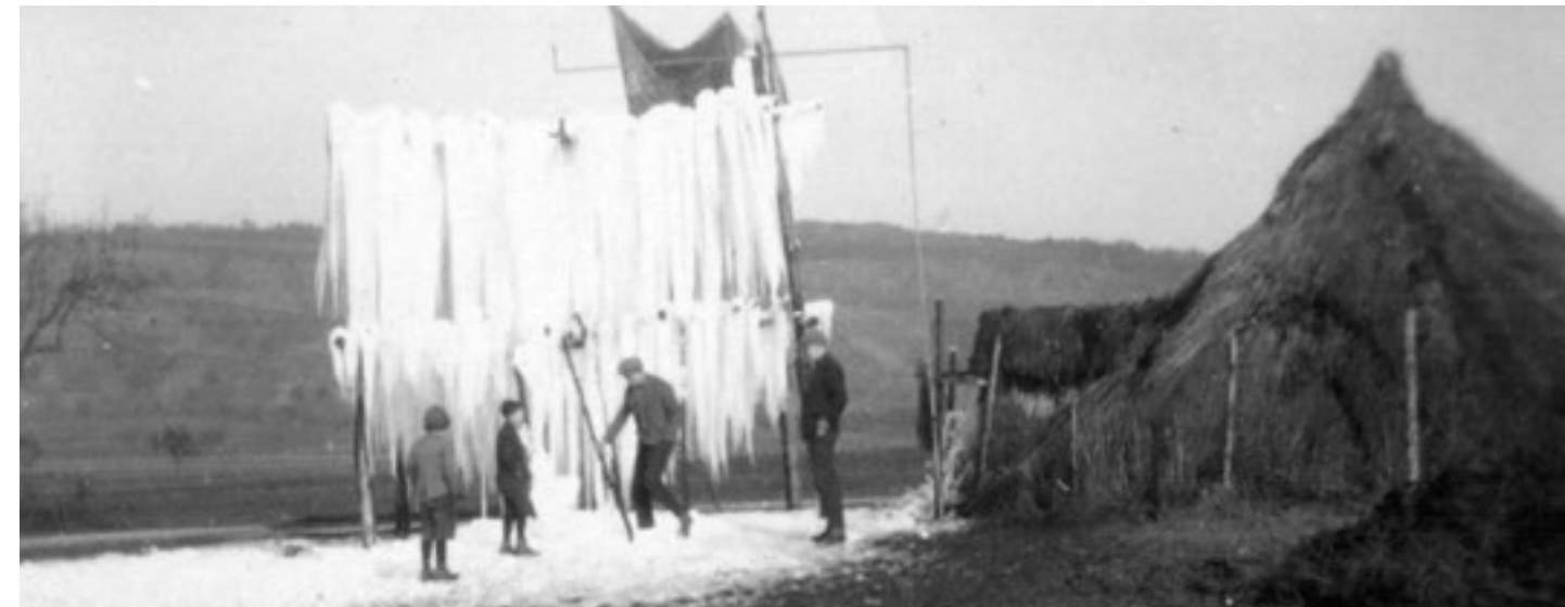
Eisgewinnung aus dem Main in den 1930er Jahren: Das Gestell wurde bei Temperaturen unter dem Nullpunkt mit Wasser bespritzt. Das entstehende Eis wurde dann zur Lagerung über das Jahr in den daneben stehenden Strohtempel gebracht.
