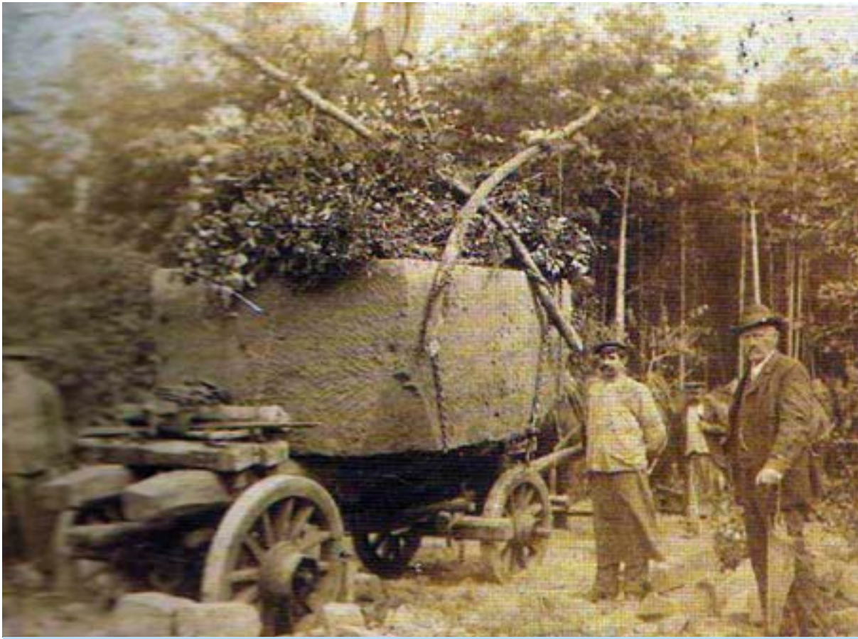
Der Transport der großen Steinquader den Berg hinab war sehr gefährlich. Die Sicherung durch quergespannte Äste mutet heute abenteuerlich an - damals behalf man sich so gut es ging; Foto von 1896 aus dem Miltenberger Steinbruch der Fa. Zeller.
