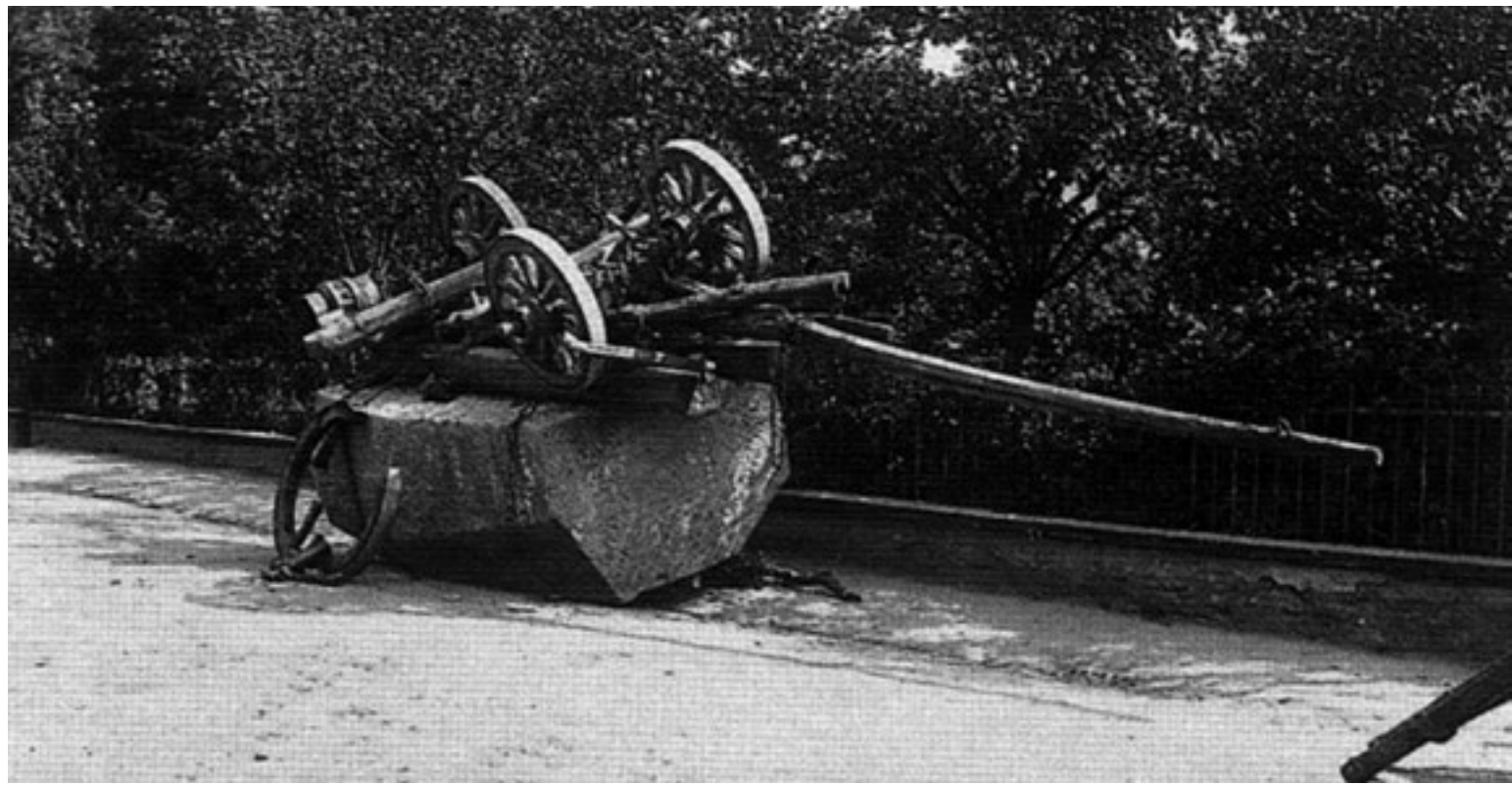
Unfälle sind beim Transport solch großer Lasten unvermeidlich - hier ein Achsbruch im Jahr 1907 in Miltenberg (Foto der Fa. Zeller).
