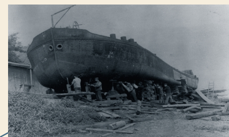
Der Rumpf eines Mainschiffs in Bau.
