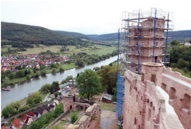
Der kleine Bergfried der Henneburg war im vierten Bauabschnitt eingerüstet. Foto: Burglandschaft
