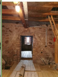
Der am Dachboden sichtbare Giebelansatz gehört zur zweiten Bauphase. Foto: Burglandschaft
