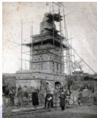
Der Kamin des Kalkgas-hochofens im Bau
